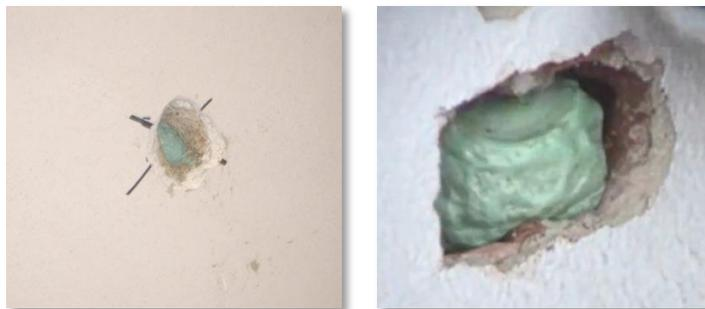
Orificios de inyección rellenos, antes del sellado
