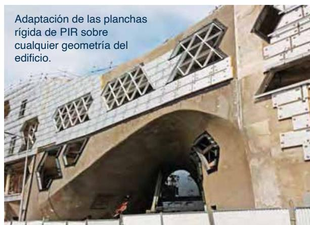
Adaptación de las planchas rígidas de PIR sobre cualquier geometría del edificio.
