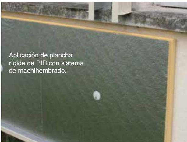
Aplicación de plancha rígida de PIR con sistema de machihembrado.
