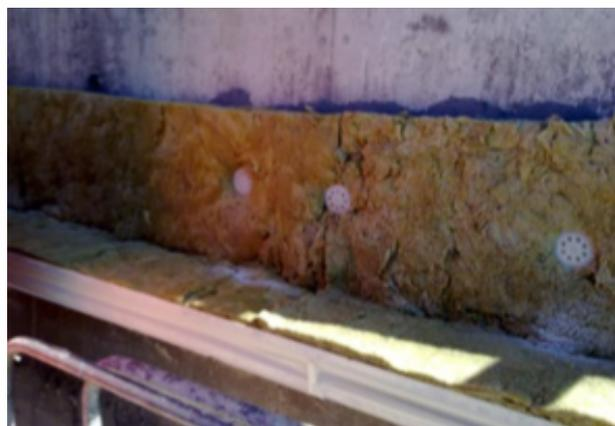
Ejemplo de sectorización mediante barrera cortafuegos E 30 en fachada ventilada.
