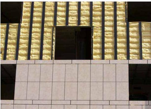
Adherencia, continuidad, impermeabilidad y adaptabilidad garantizan la protección frente al agua de la fachada y el aislamiento.
